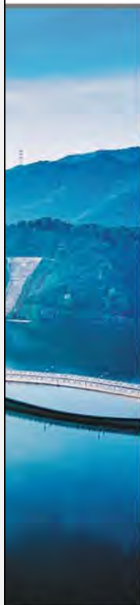
配水工程闲林枢纽
